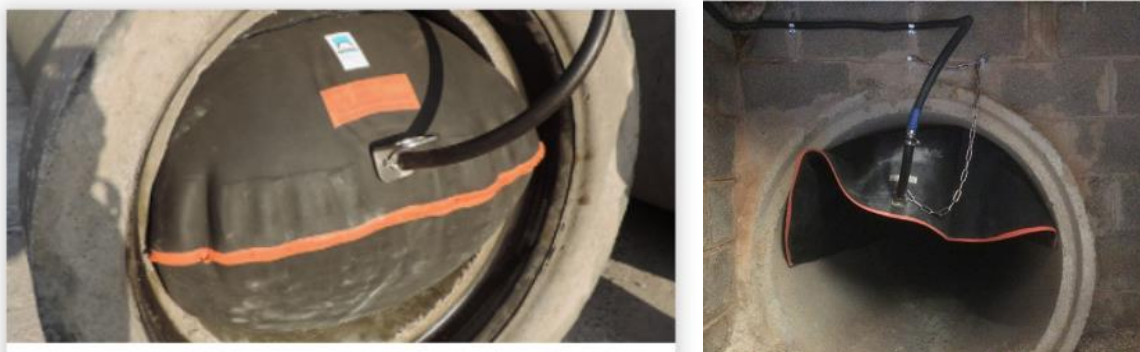
Illustration 12 - Exemple d'obturateur gonflable
